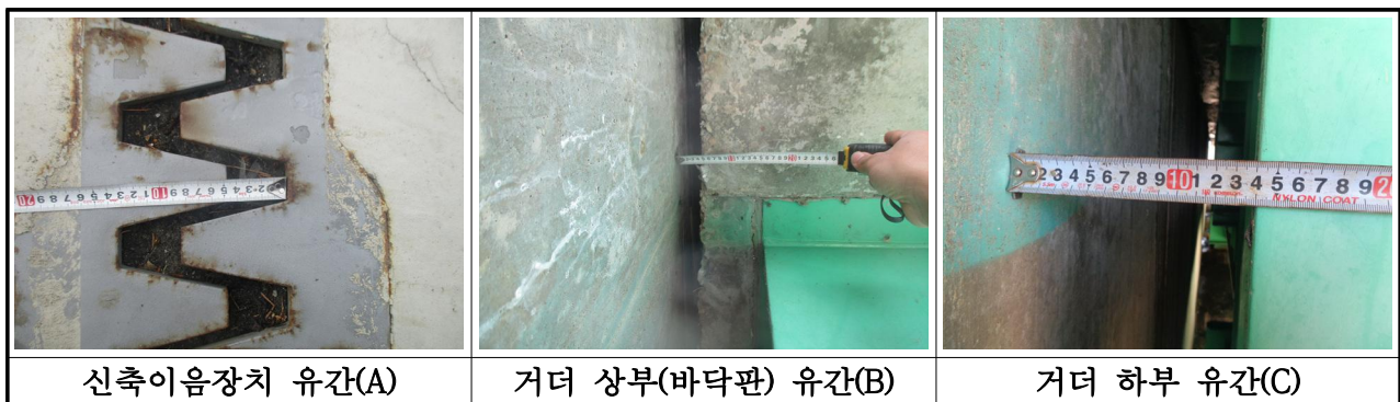
【사진 3.19】 신축이음 유간 측정방법
