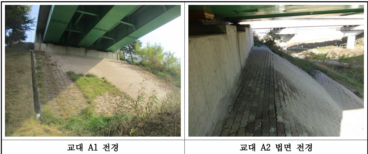
【사진 3.11】 교대 전경
