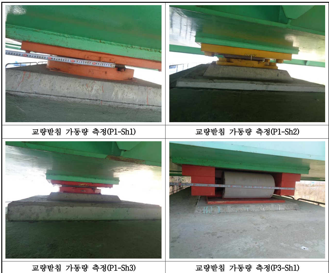
【사진 3.16】 교량받침 가동량 측정 전경
