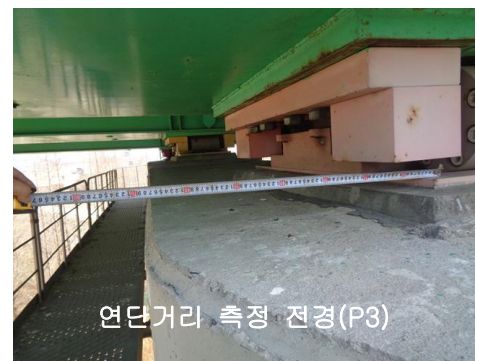
【그림 3.2】 도로교설계기준 연단거리 산출방법
