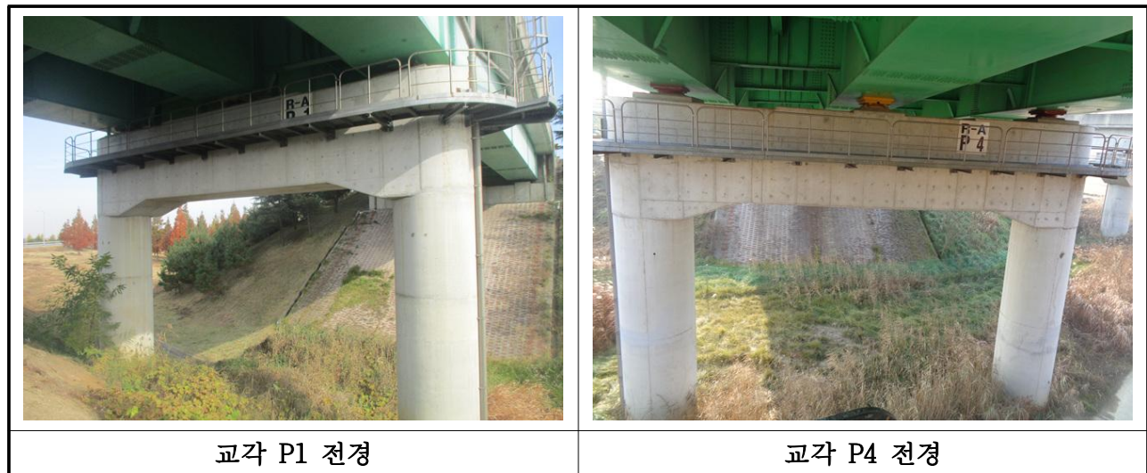
【사진 3.13】 교각 전경
