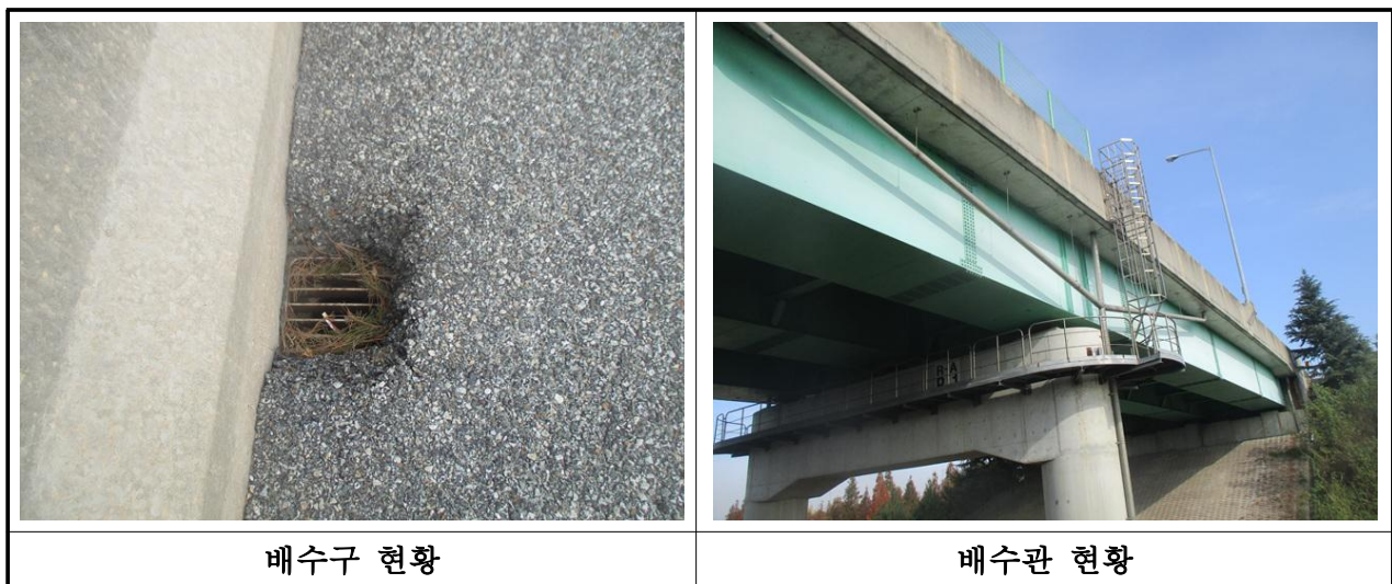
【사진 3.21】 배수구 및 배수관 전경
