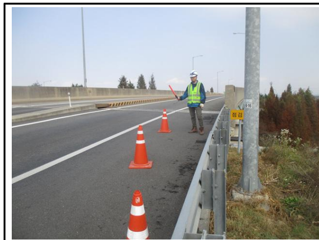
교통통제 후 교면포장, 방호울타리 조사
