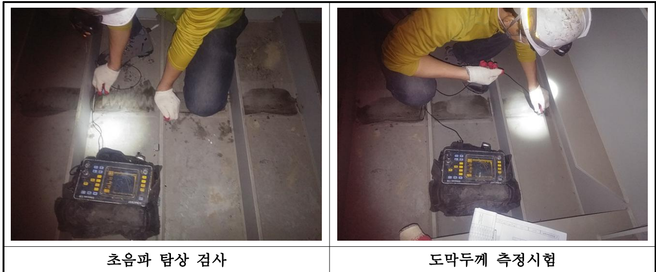
【사진 3.26】 강재 내구성조사 전경
